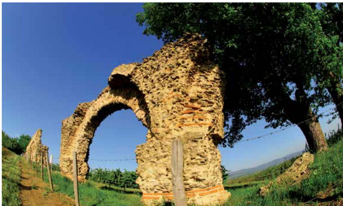
Aqueduc romain du Gier à Soucieu-en-Jarrest
